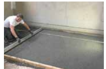
EINBRINGUNG GEBUNDENER SPLITT
