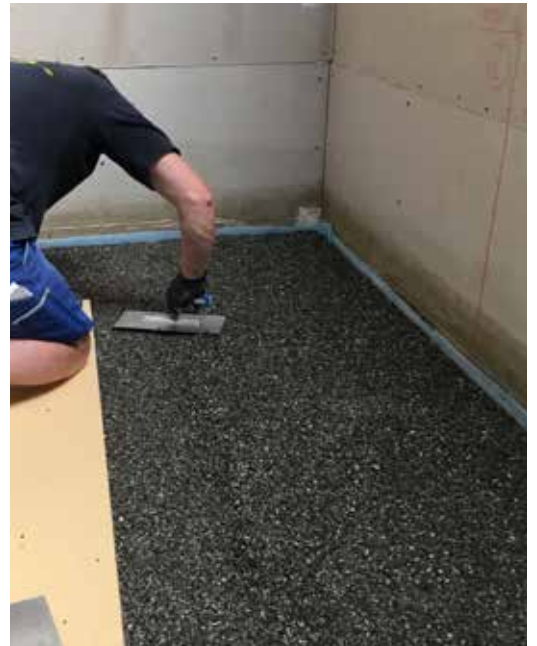
BILD: WOLF BAVARIA - LOSE SPLITTSCHÜTTUNG
